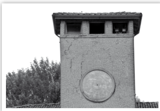
La torre dell'orologio del castello di Ronchi dopo la prima scossa
