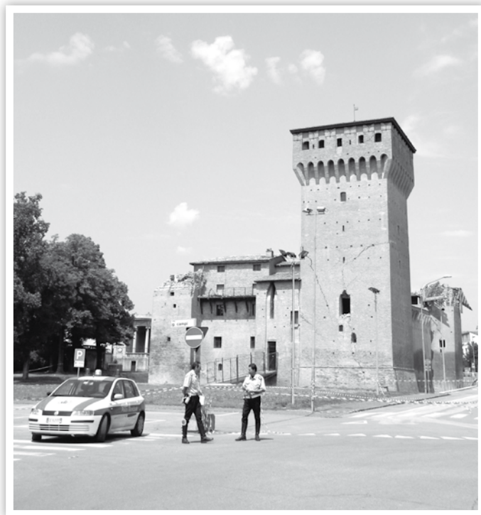
San Felice sul Panaro. La rocca, danneggiata, presidiata
