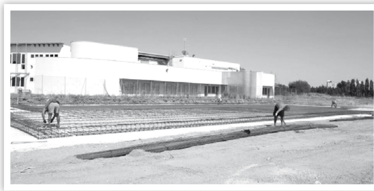
La predisposizione della platea di fondazione dell'edificio scolastico temporaneo che ospiterà 8 classi, accanto alle Romagnoli.
