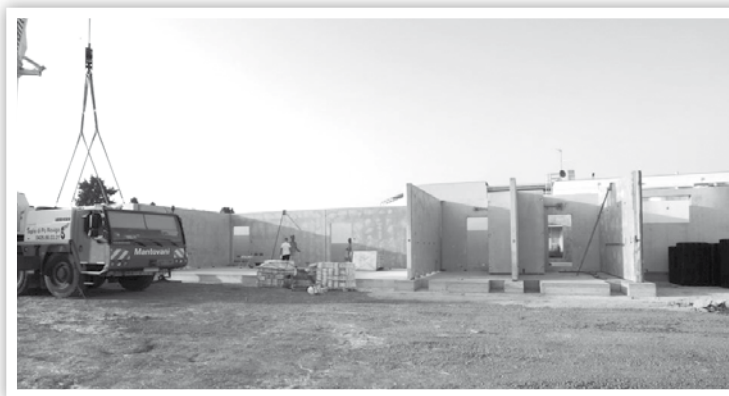
Innalzamento delle pareti delle strutture prefabbricate
