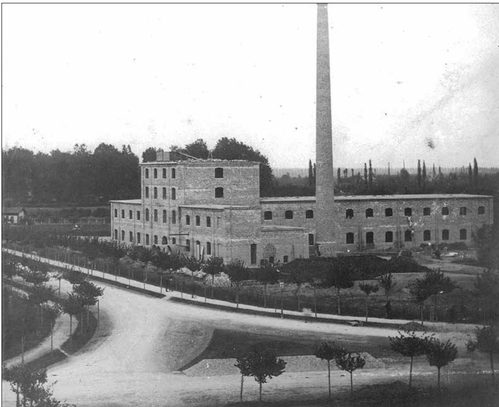
La fecoliera in costruzione (Foto Marchignoli)
