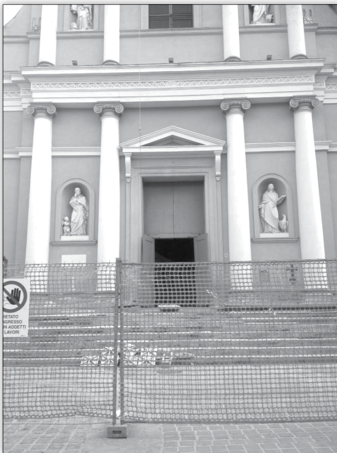
I lavori visti da fuori (R.Cocchi)
